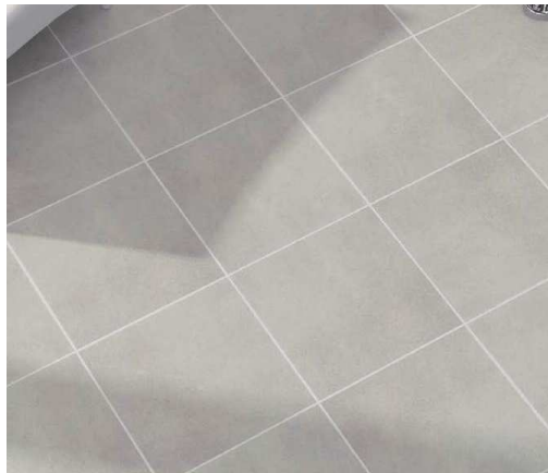
Paviment tipus de gres antilliscant per exterior
